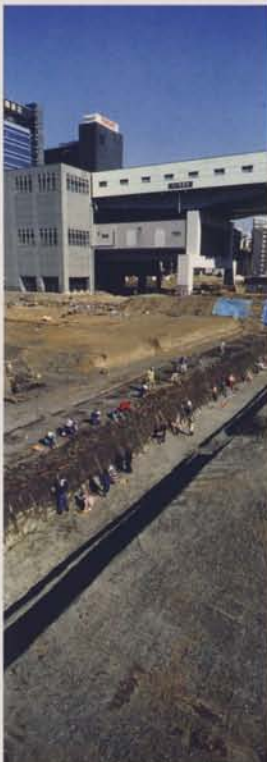
土留め竹柵(伊達家屋敷)
