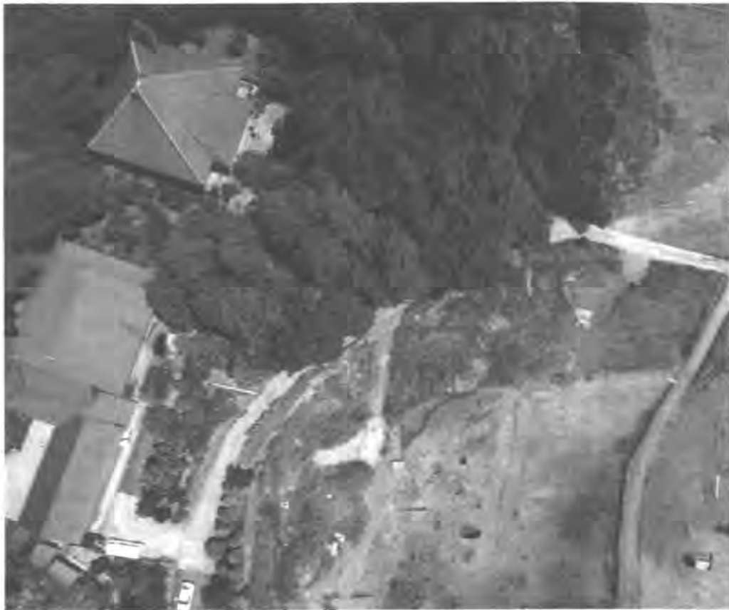
空からみた蓮生寺とNo.692遺跡
