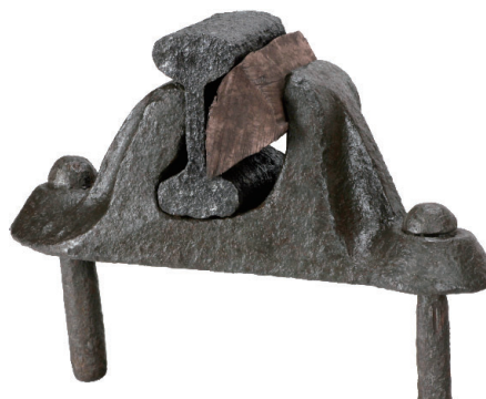
チェアーによる双頭レールの固定方法の再現
