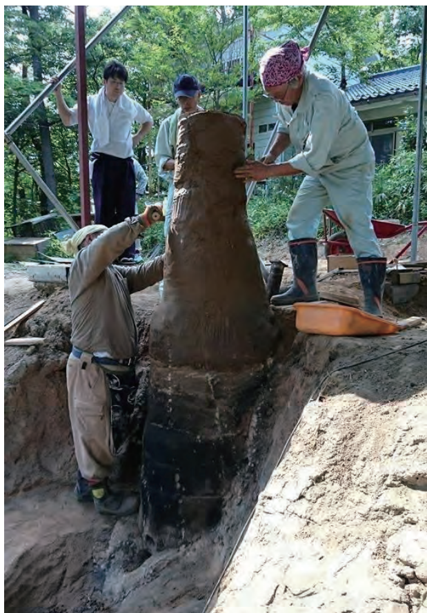
写真3 豎形炉の復元状況
