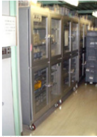
しゅうそうこ 収蔵庫内に設置された 減湿キャビネット
