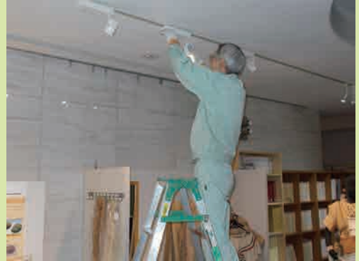
展示ホール内の照明を取り替える
