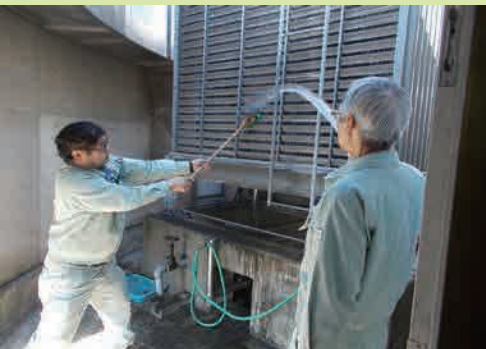
屋上の冷却装置を掃除する
