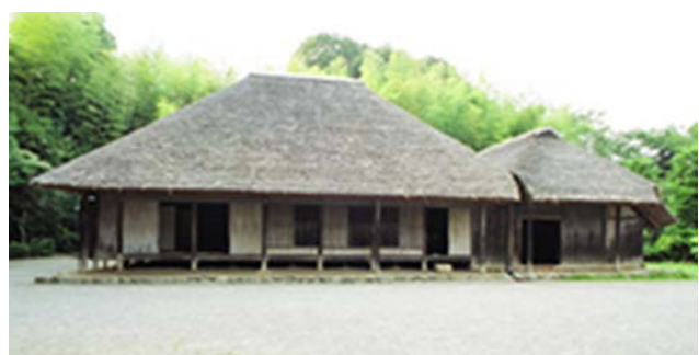
分棟型民家（千葉県作田家住宅／川崎市民家園移築）
