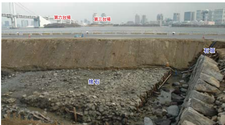
北面の石垣と旧海面下に敷かれた捨石（第三・第六台場を望む）【2012年度調査】
