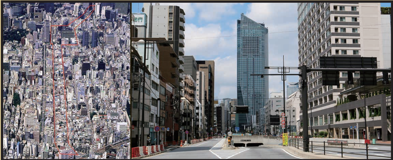
写真1：調査前(2004年)の「環二通り用地」(左、赤線枠内)と、道路が開通した現在の様子(右)。右写真の中央手前には「築地虎ノ門トンネル」が、中央奥には「虎ノ門ヒルズ」がみえる。(左写真：東京都都市整備局再開発事務所提供)
