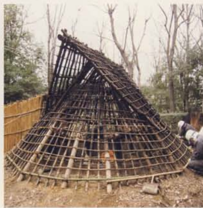
2. 修復 傷んだ垂木を補強する
