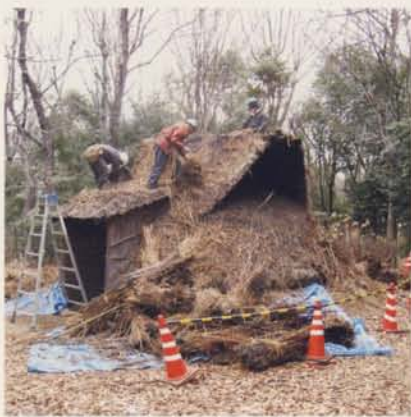
1. 解体 上から順に茅を取り外す
