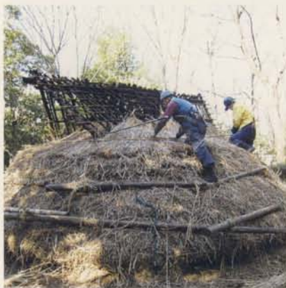
4. 平葺き 足場を組みながら葺いていく
