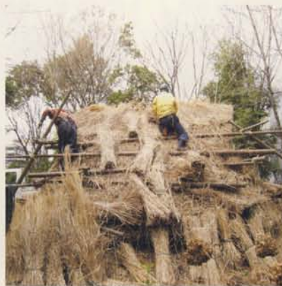
5. 平葺き 針を使いワラ縄で茅を固定
