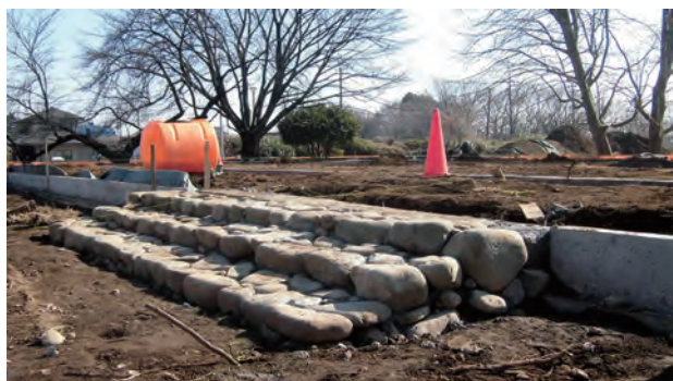
国史跡武蔵国分寺跡僧寺講堂跡 基壇復元工事のようす
