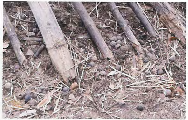
根元の朽ちた垂木と集められたクルミ（解体時に撮影）
