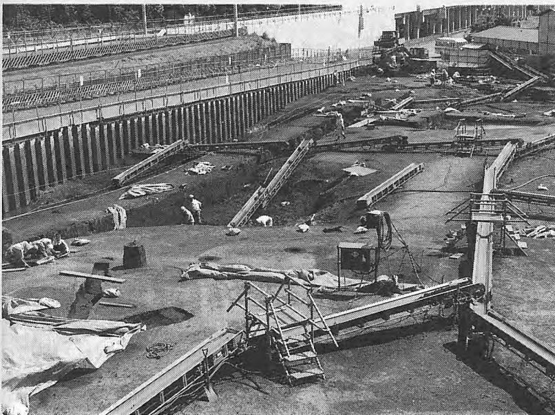
沖積部分の調査風景
