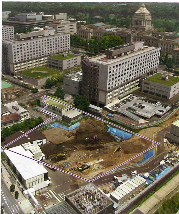
7 調査地点全景（衆議院議員会館地点） 枠線内が調査地点、中央が旧衆議院第一議員会館、右上が国会議事堂
