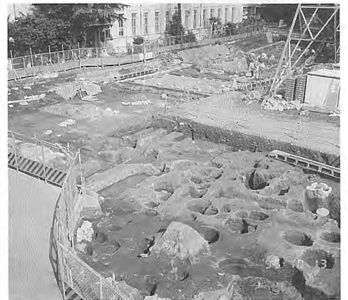
尾張藩東御殿の表玄関付近
