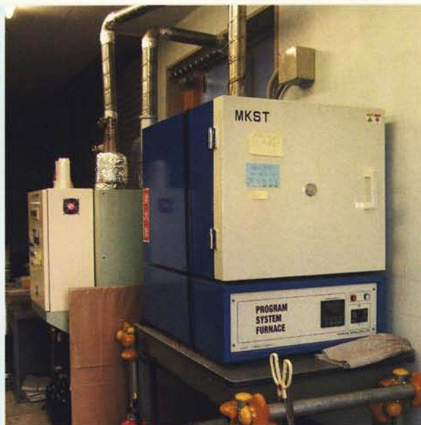
電気炉（右手前）と排気ガス処理装置（左奥）
